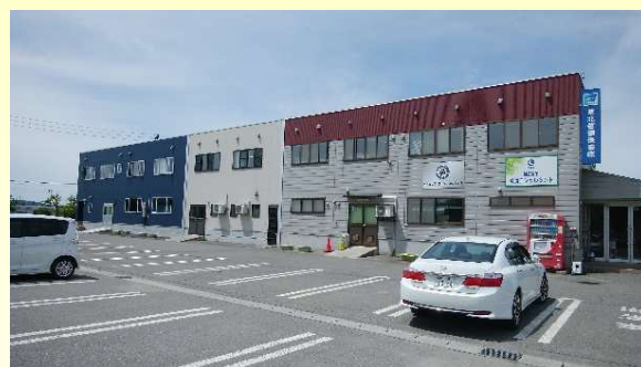
社屋全景。1階は系列会社のネクスト環境コンサルタントが使用しています。2階は事務室等で主に当社が使用しています。2021年2月に増築工事（写真左奥）が完成しました。
